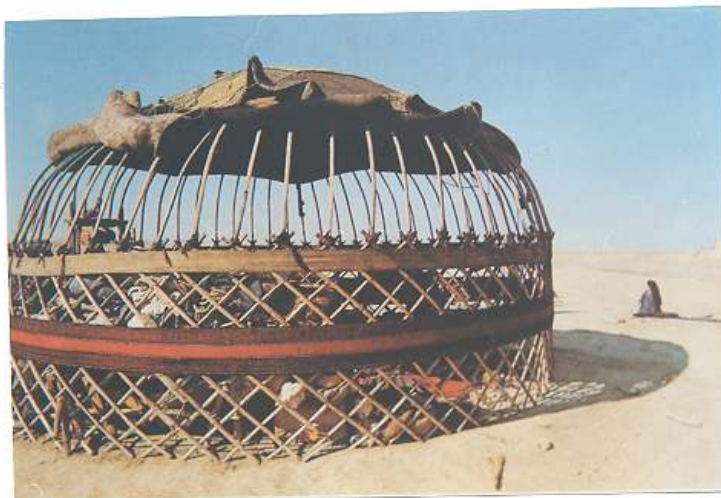
اسکلت آلاچیق (چادر) ترکمن در منطقه مراوه تپه (شمال شرق گنبد)
